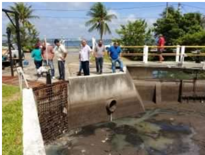
Figura 4 – Abertura da comporta do sistema de coleta em tempo seco após fortes chuvas em Cabo Frio (2022). Fonte: Site oficial da prefeitura de Cabo Frio
