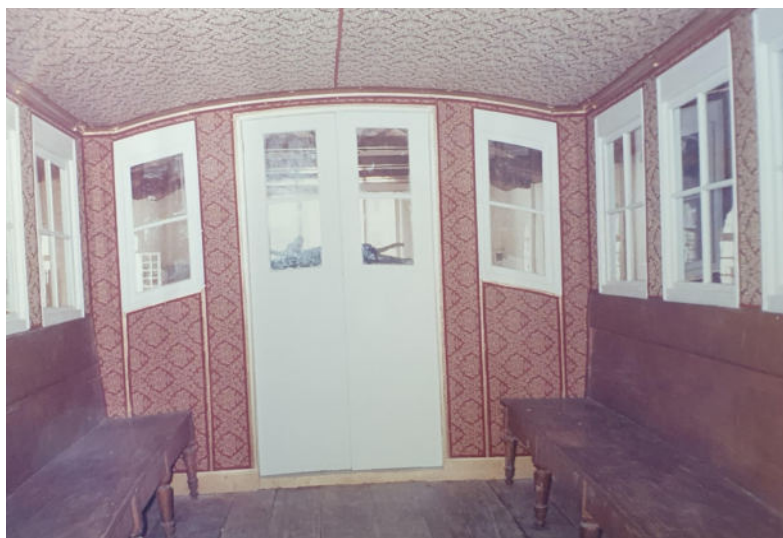
Figura 16 - Processo de restauro do camarim, 2008, revestimento
