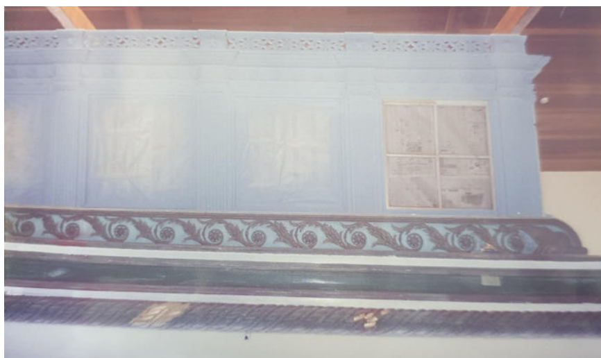
Figura 13 - Processo de restauro do camarim de 2008, pintura externa
