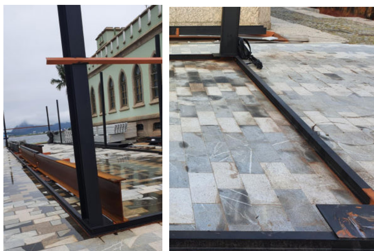
Figuras 44 e 45 - Estrutura desmontada para entrada da Galeota
