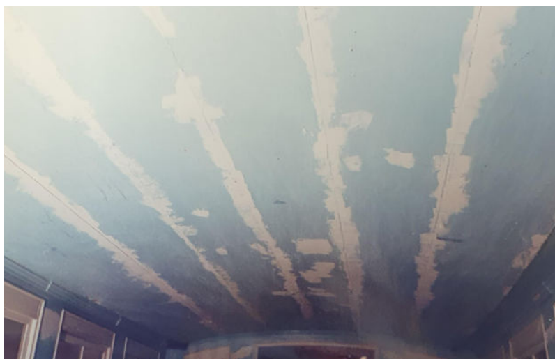
Figura 14 - Processo de restauro do camarim de 2008, nivelamento para pintura interna
