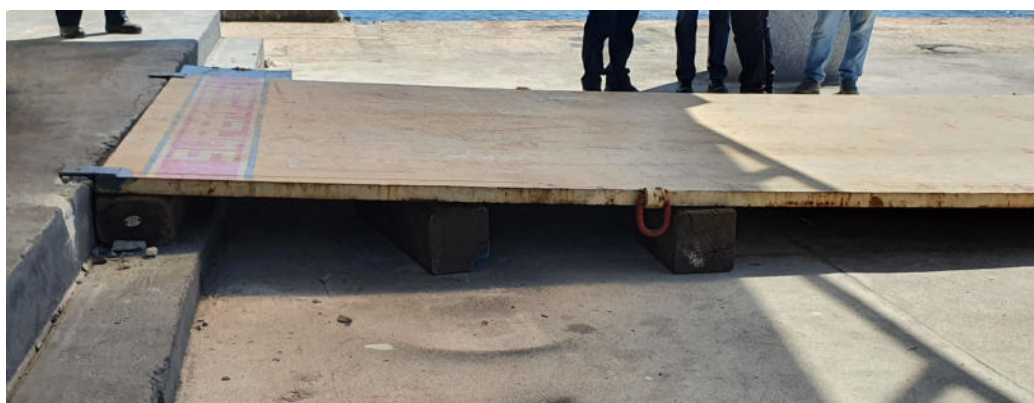
Figura 34 - Prancha metálica nas escadas para descida da Galeota
