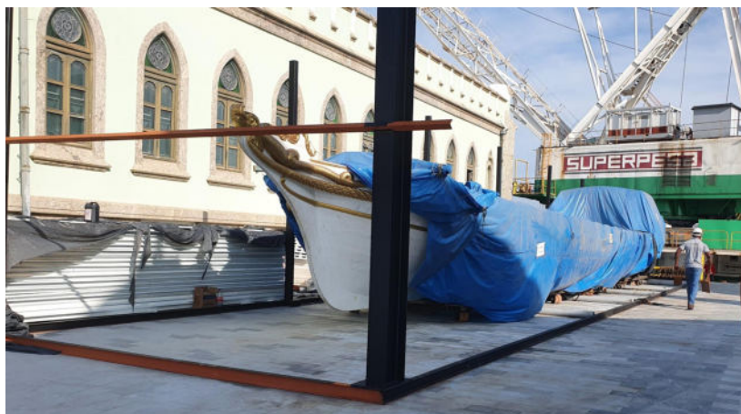
Figura 46 - Retirada dos tubos de içamento
