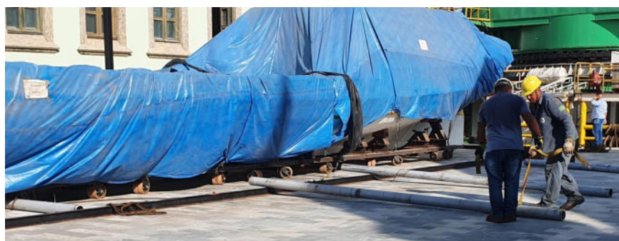
Figura 47 - Retirada dos tubos de içamento
