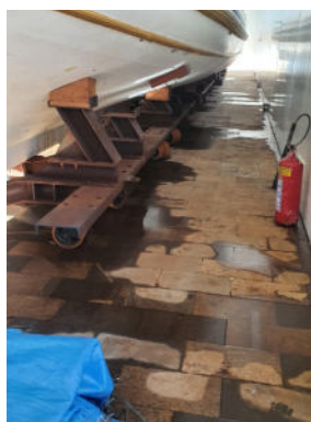
Figura 61 - Acúmulo de água na vitrine
