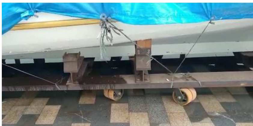
Figura 56 - Empoçamento após as chuvas
