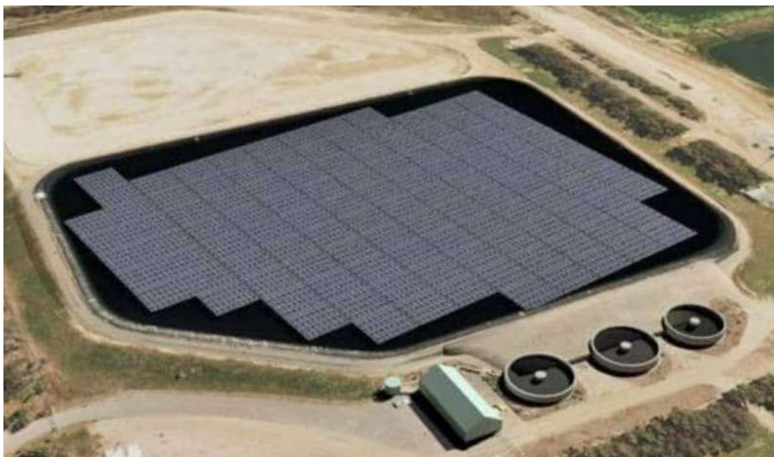
Figura 10: Tecnologia Evap-mat cobrindo um reservatório em 90% (BIG DITCH, 2019).
