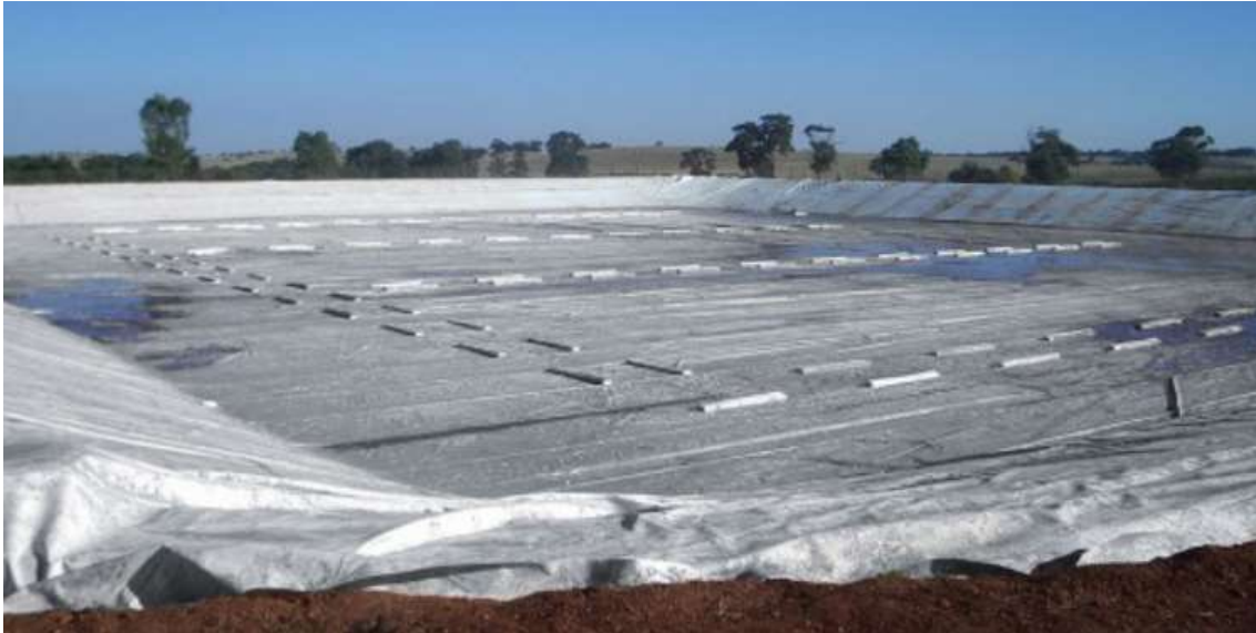
Figura 9: Reservatório coberto com a tecnologia E-vap Cap (BIG DITCH, 2019).
