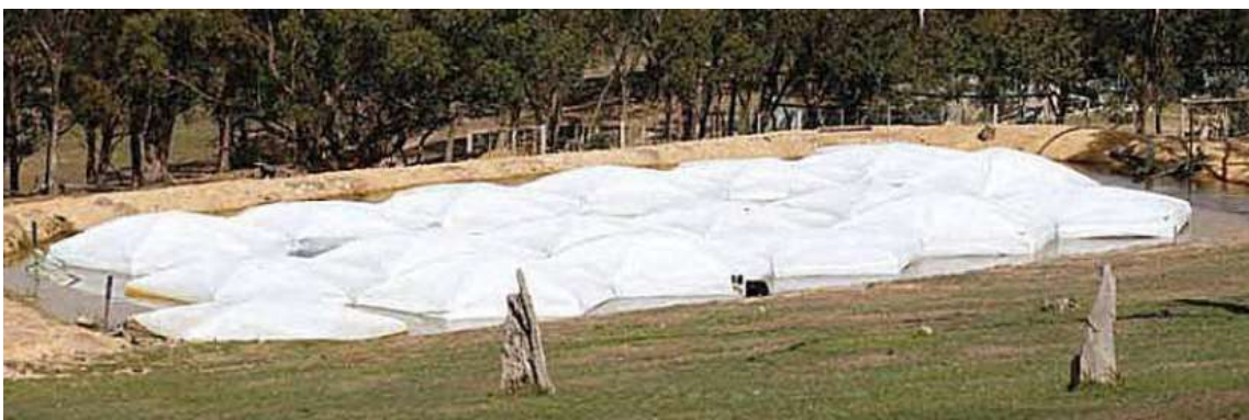
Figura 7: Tecnologia Raftex para cobrir reservatórios (BIG DITCH, 2019).
