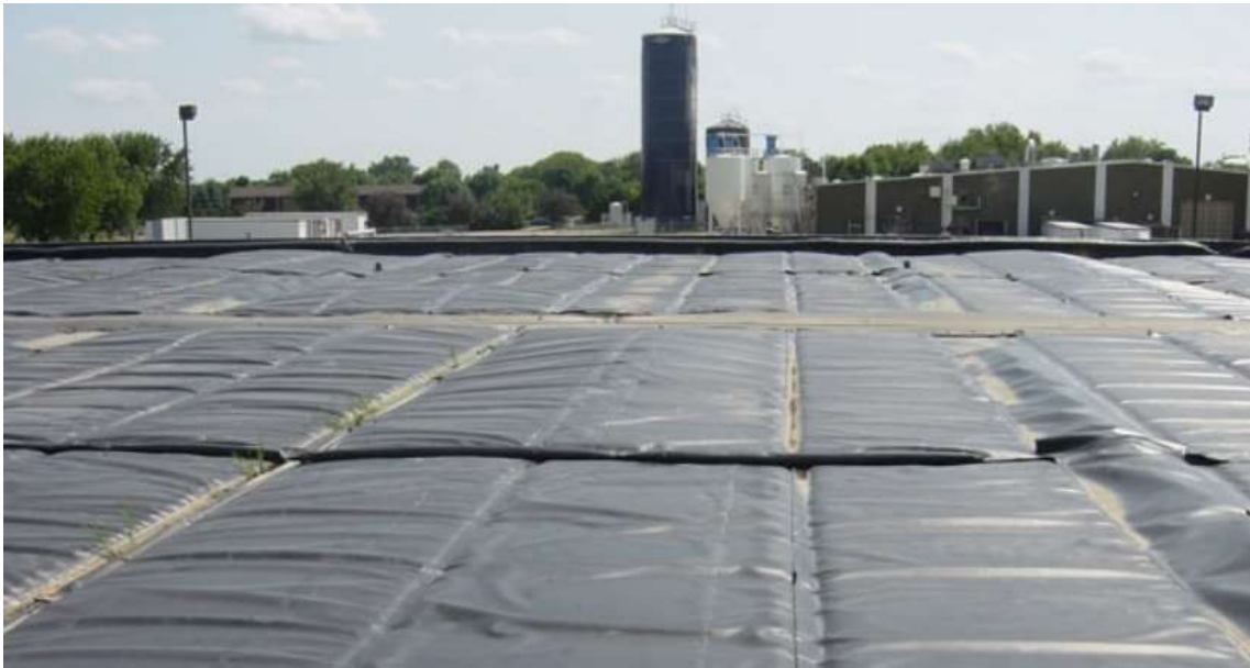
Figura 6: Tecnologia Quit Evap cobrindo um reservatório (BIG DITCH, 2019).
