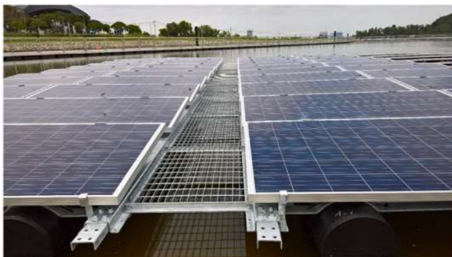
Figura 21: Modelo Upsolar com SERIS instalado na bacia de Tiengheh em Singapura (CAZZANIGA et al., 2017).
