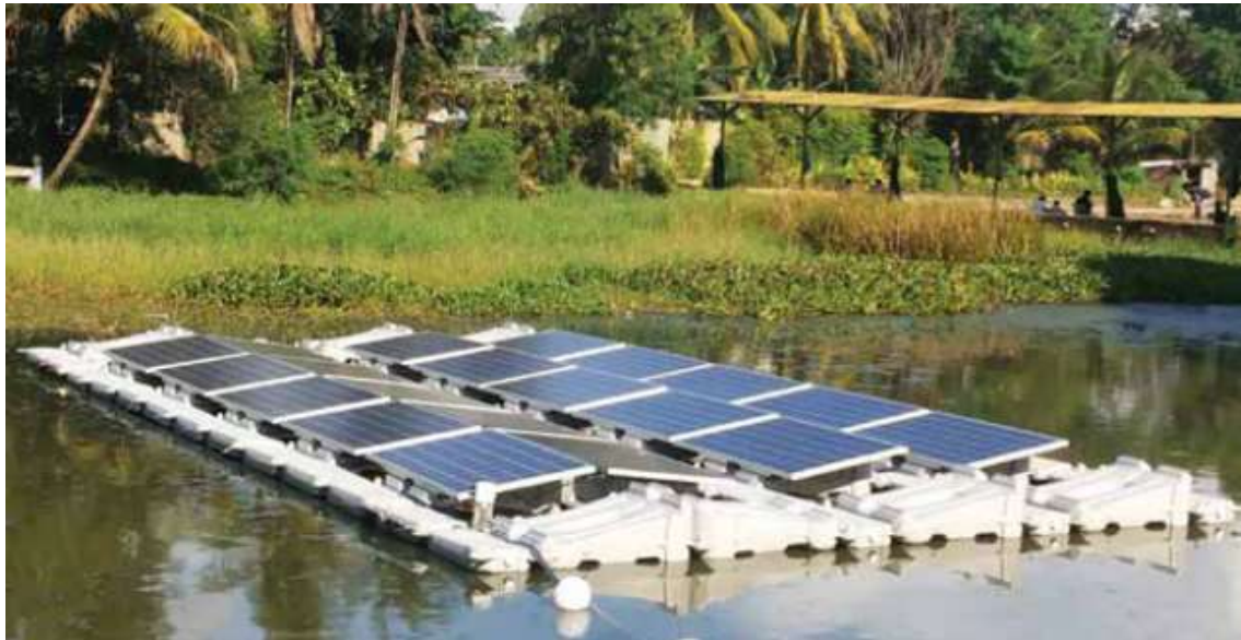
Figura 26: Tipo mais comum de flutuantes usados no mundo para UFVF – Modelo Ciel et Terre.
