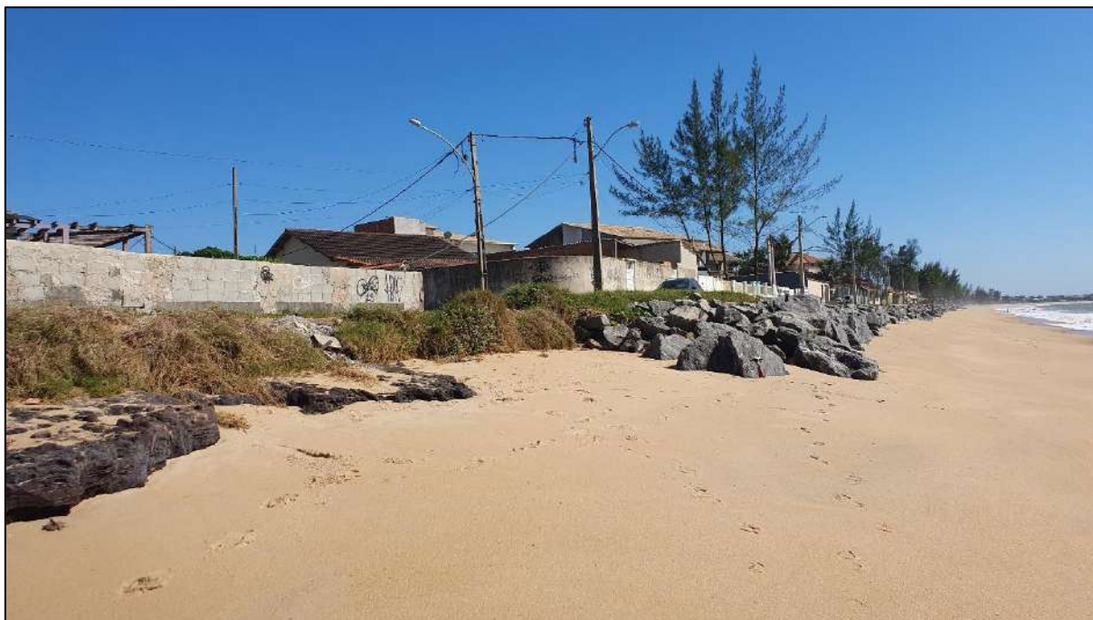
Figura 21 - Limite do afloramento de arenitos ricos em matéria orgânica, à esquerda, com o enrocamento realizado na Praia do Abricó pela Prefeitura do Município de Rio das Ostras, à direita.
