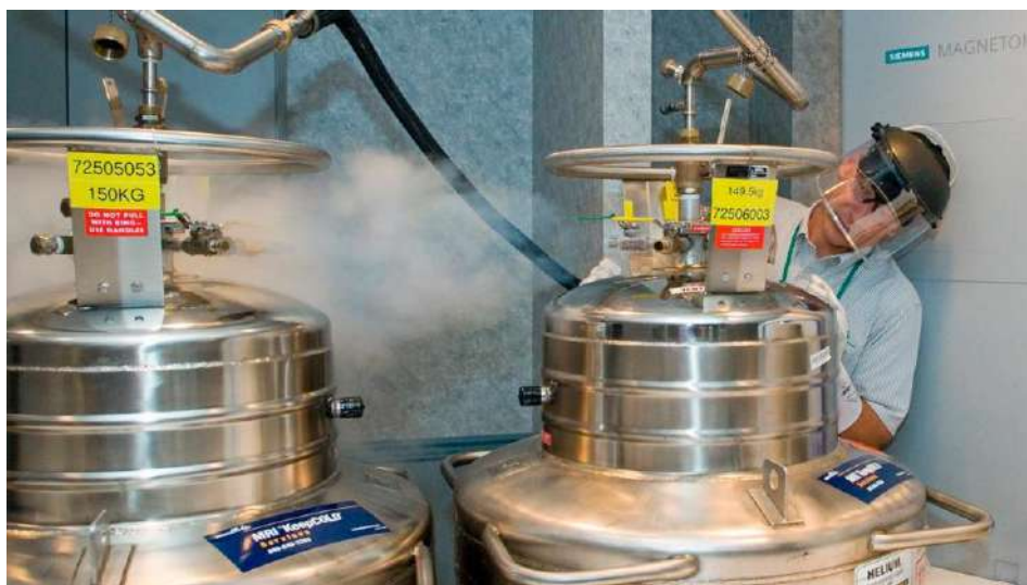
Figura 7 - Recarga de hélio líquido em equipamento de ressonância magnética Fonte: Air Products
