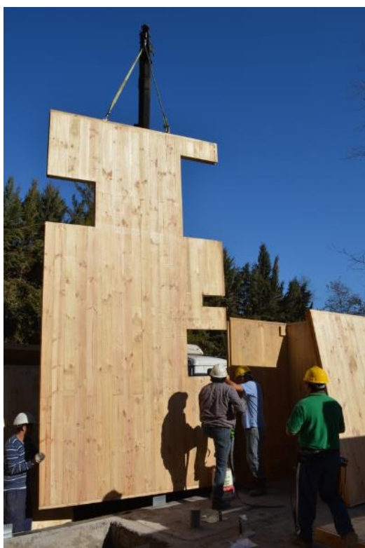
Figura 4: Encaixe de painel feito de Madeira Laminada Cruzada (CLT)
