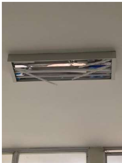
Figura 17 - Danos na luminária Fonte: PEMM/COPPE/UFRJ (2018).
