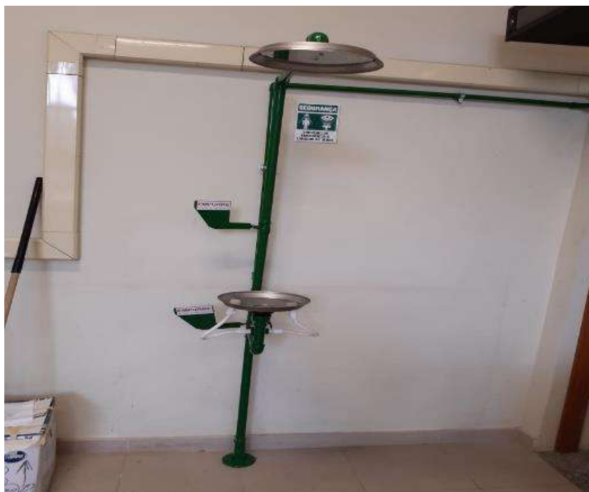
Figura 26 - Chuveiro instalado no laboratório
