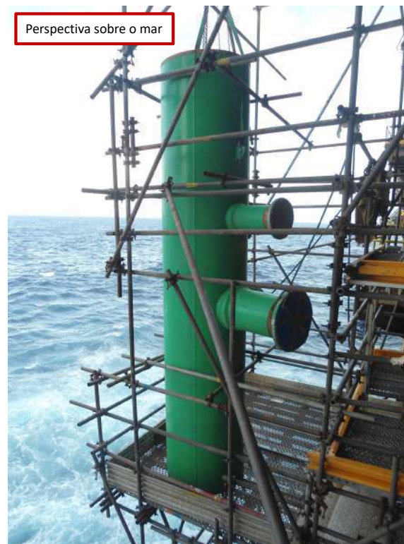
Figura 34 – Estrutura montada para o reparo na linha de 40" do caisson de overbord
