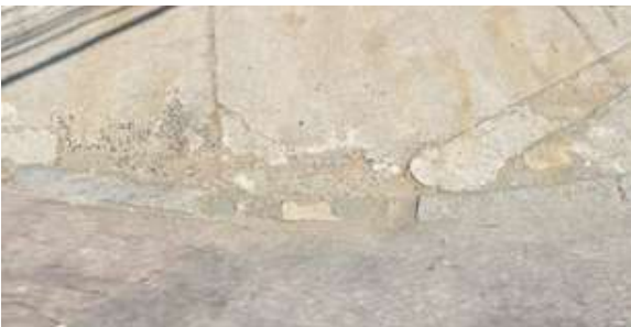
fig 23 - Calçadas desgastadas pelo peso de carros.
