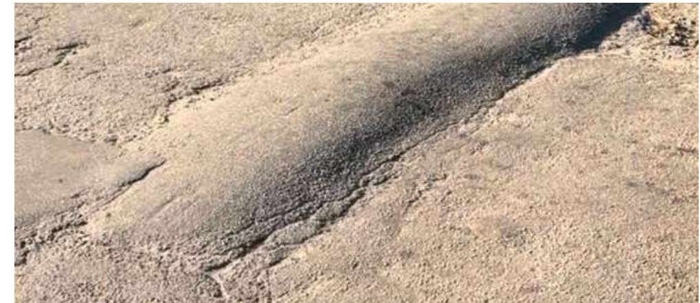
fig 18 - Autoral. Lombada irregular perante os requisitos de sinalização e dimensão previstos pela NBR 16590/2017 e resoluções do CONTRAN. No entorno da E.M. Júlio Verne.
