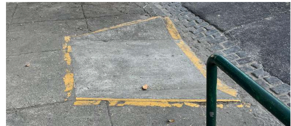
fig 20 - Autoral. Rampa com sinalização de pintura falha. Em frente à entrada principal da E.M. Júlio Verne.
