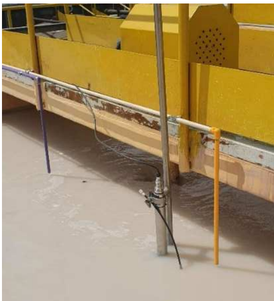
Figura 11 – Sensor Viomax CAS51D instalado na caixa de gordura
