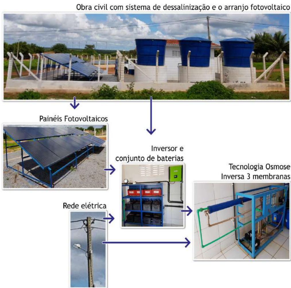
Figura 16 - Projeto piloto com arranjo fotovoltaico associado ao sistema de dessalinização implementado pelo Programa Água Doce na comunidade Maria da Paz. Fonte: Elaboração própria.
