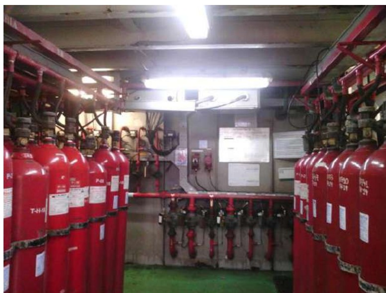
Figura 19 - Foto parcial da sala dos cilindros de CO 2
