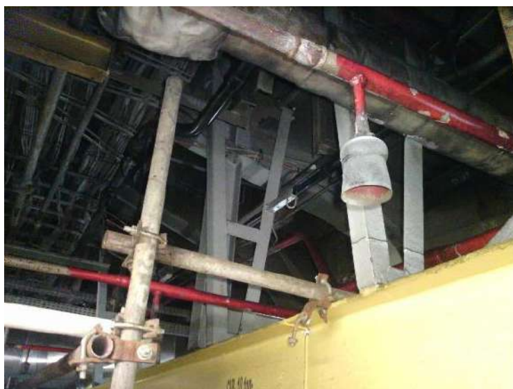
Figura 23 - Aspensor de CO 2 na sala dos EMD's
