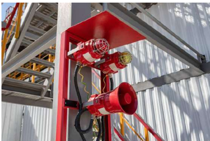
Figura 16 - Giroflex e alto-falante de sistema de incêndio
