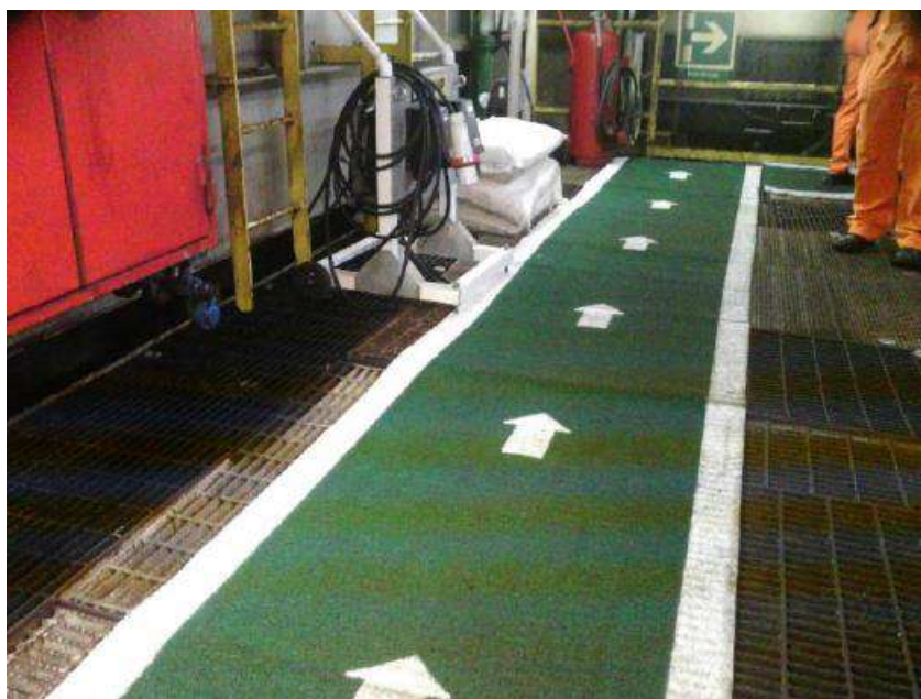
Figura 21 - Tapete com indicação da rota de fuga da sala dos EMD's
