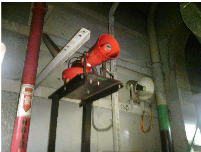
Figura 22 - Conjunto de alarmes de CO 2 e geral da plataforma
