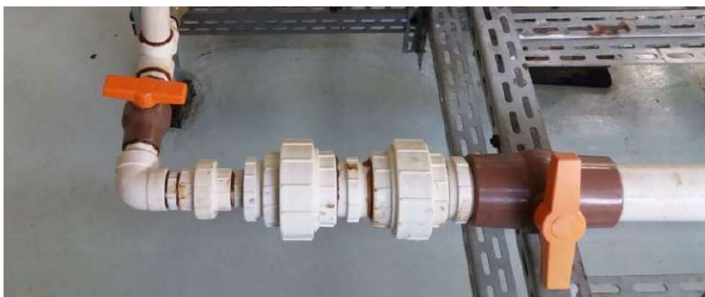
Figura 33. Dispositivo retificador de fluxo
