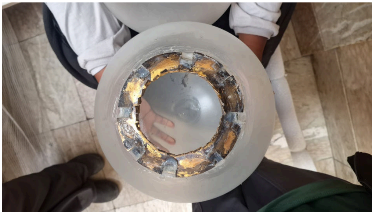
Figura 15. Apoio para globo, com ferrugem e pintura de mica.
