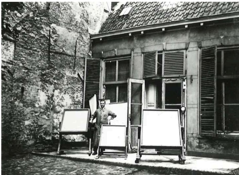
Figura 19 - Grandes molduras de madeira reclináveis, montadas com papéis translúcidos junto dos papéis fotossensíveis e expostas à luz solar, ativando o processo reprodutivo, 1901.
