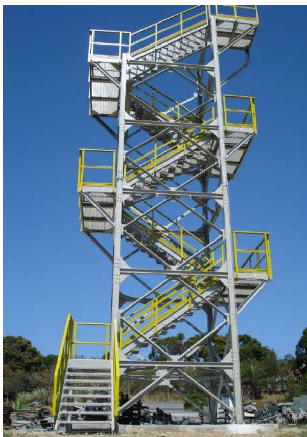
Figura 1.4: Torre construída em perfis pultrudados PRFV.
