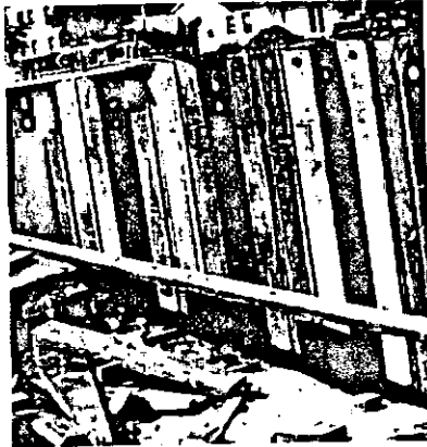
Escoramento típico de estacas - pranchas de aço
