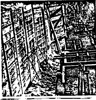
Escoramento típico de perfis metálicos e pranchões de madeira
