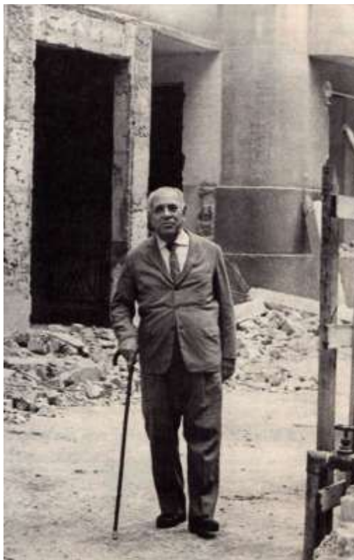
FIGURA 16 – Epitácio Timbaúba vê os últimos vestígios do mistério: o Edifício Itabira sendo demolido
