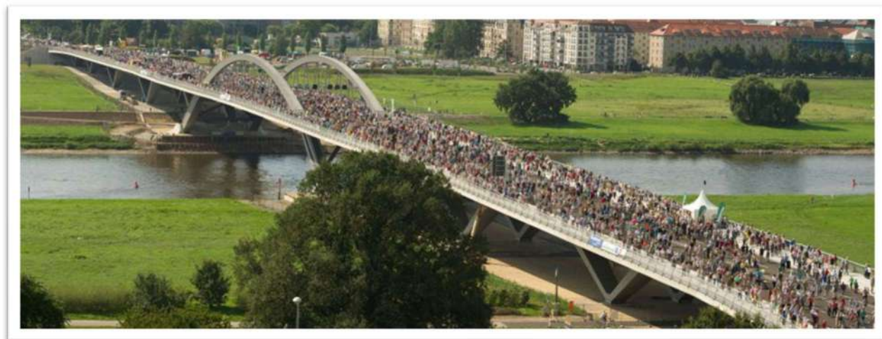
Figura 49: Ponte Waldschloesschen (Ponte sobre o Rio Elba, Dresden, Alemanha, cuja construção levou à exclusão do sítio da Lista do Patrimônio Mundial)
