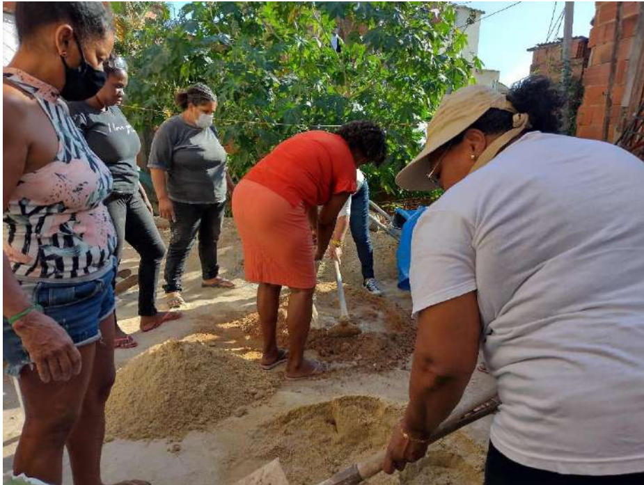
Figura 11 — Preparação da massa para emboço.
