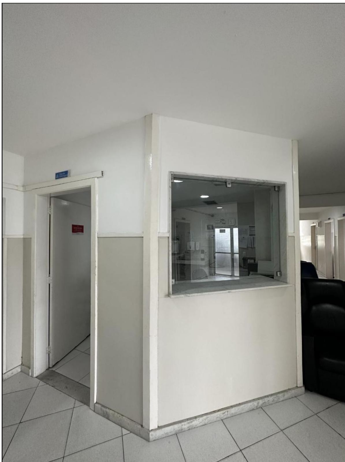
Figura 17 – Posto de enfermagem da Unidade de Emergência
