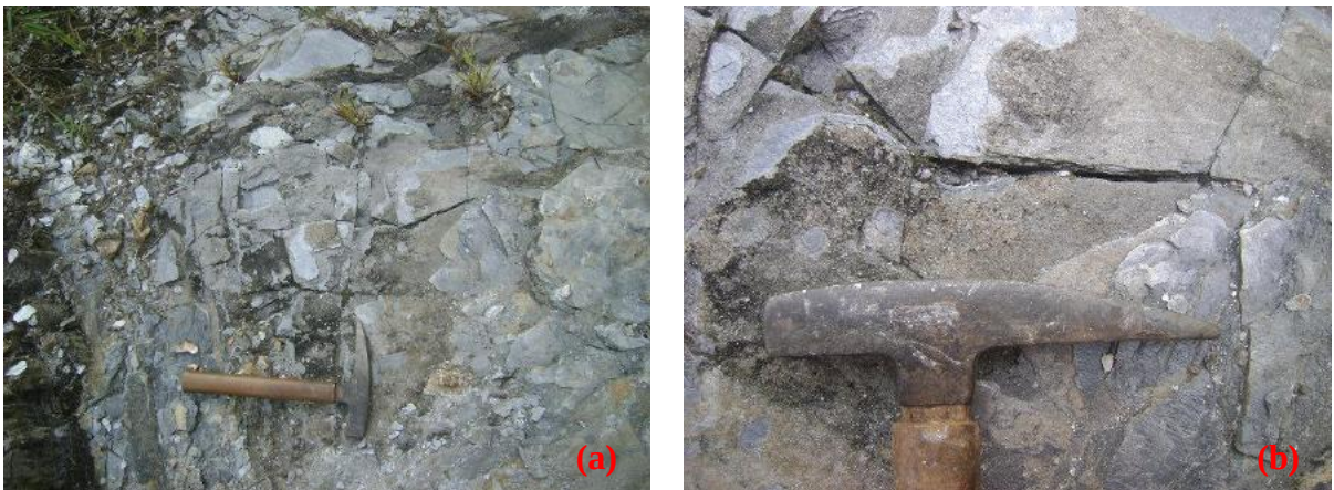
Figura 34 Em (a), detalhe de famílias de fraturas ortogonais entre si, induzindo a formação de blocos e posterior queda do perfil de intemperismo. Em (b), detalhe de abertura entre as fraturas, com média de 0,5 mm (W2).
