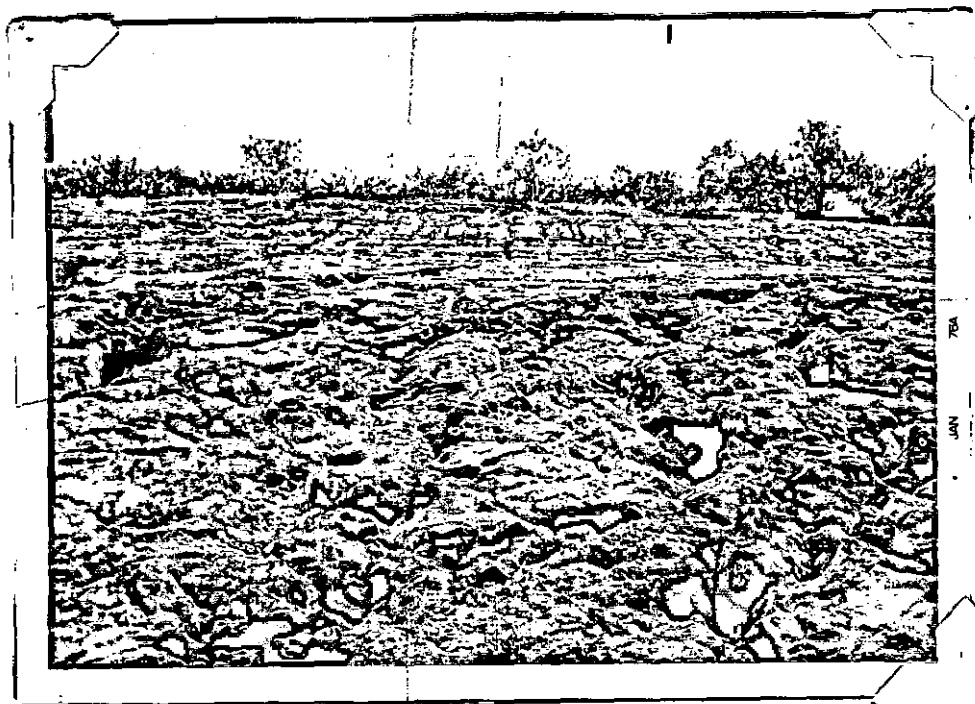
Foto 1 - Erosão por ravinamento com maior volume na parte média inferior do talude
