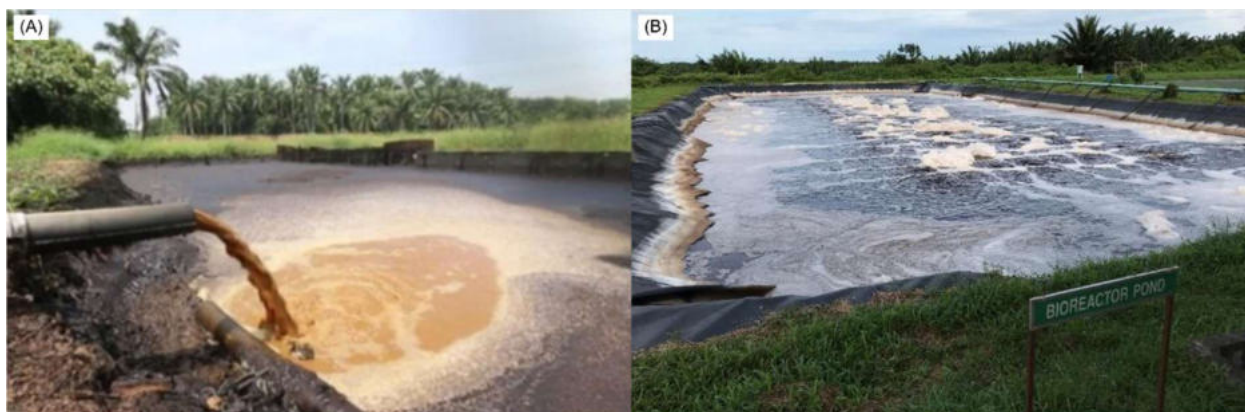
Figura 3 – Sistemas de tratamento do POME abertos para a atmosfera, os quais são comumente empregados nas indústrias de óleo de palma.
