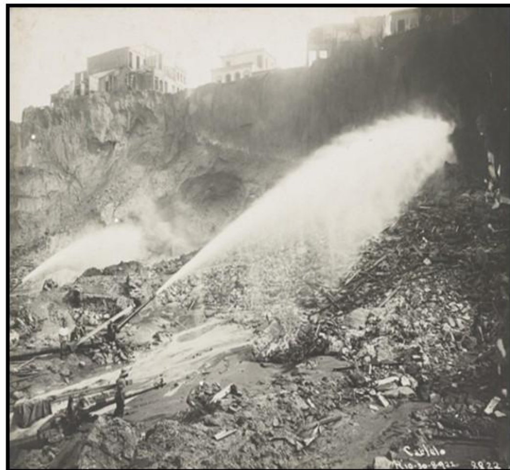
Figura 12: Jatos d'água sendo usados na demolição do Morro do Castelo
