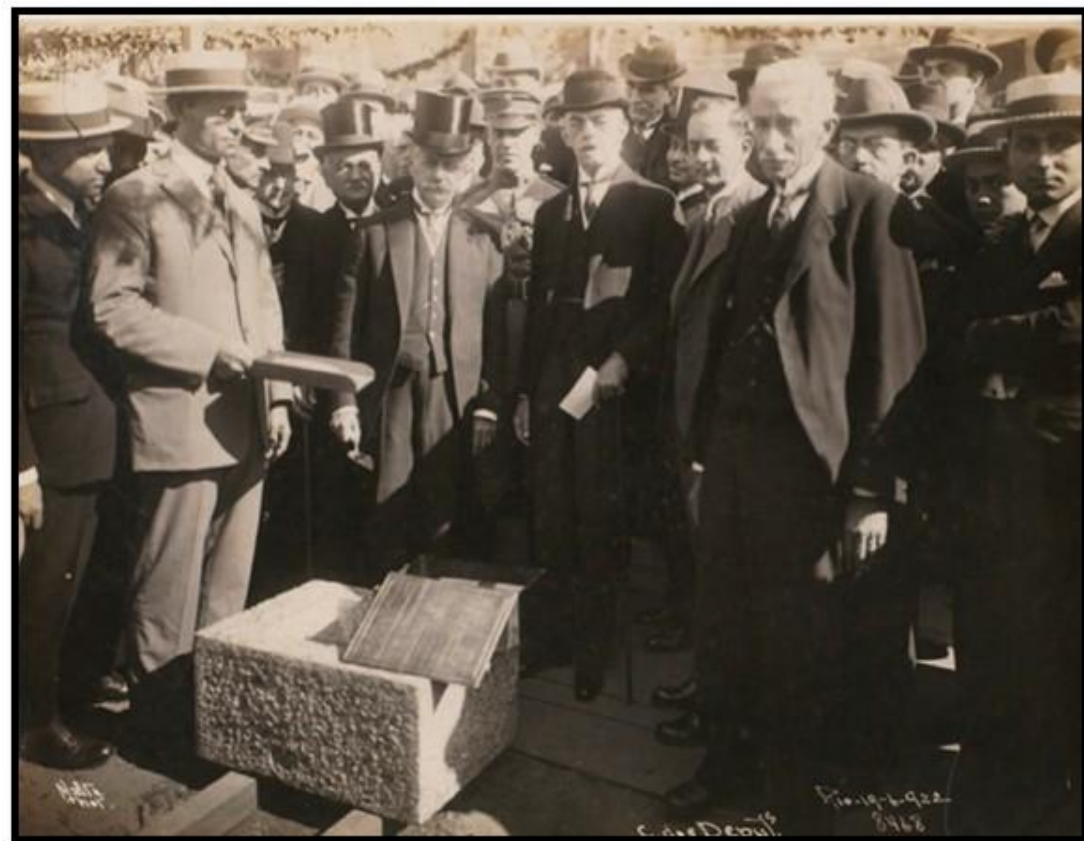
Figura 16: Observamos o chefe do executivo, Eptácio Pessoa e o Presidente da Câmara, Arnolfo Rodrigues junto com outras autoridades na cerimônia que marcou o início das obras. Nessa imagem, está sendo pavimentada a pedra fundamental do Palácio Tiradentes
