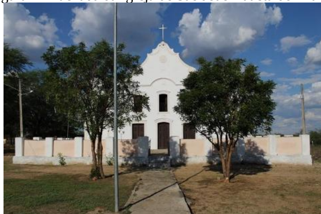
Figura 4 - Fachada da Igreja de São João Batista do Araripe
