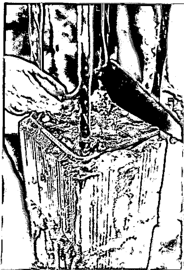
FOTO 6 - Colocação dos estribos em cada junta horizontal.
