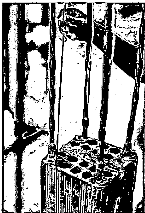
FOTO 8 - Detalhe da vibração manual dessa argamassa de in jeção com uma vareta de aço.
