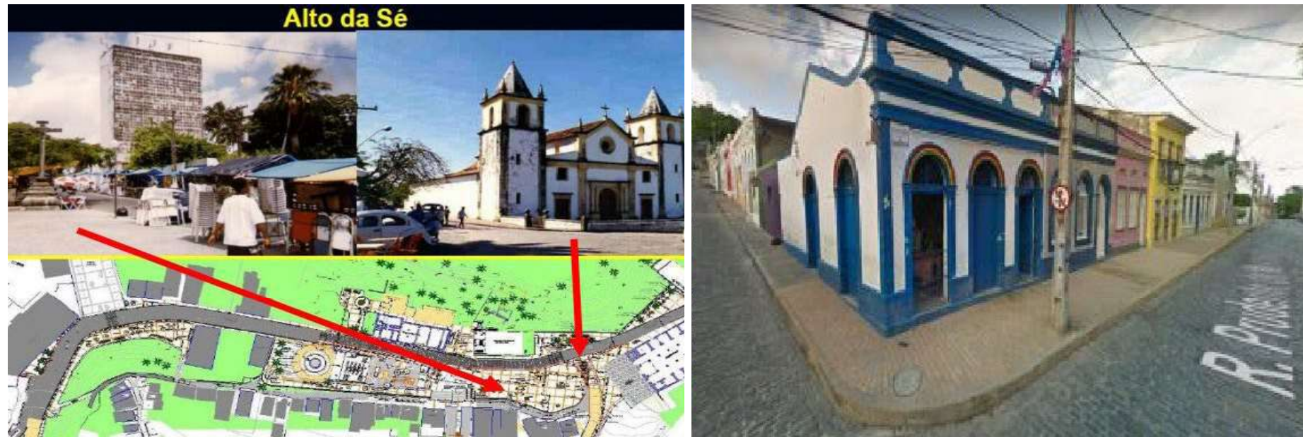
Figuras 63 e 64. Local do Projeto e exemplo de edificação do entorno do Largo. Fonte: Prefeitura Municipal de Olinda. Acesso: novembro/2023.
