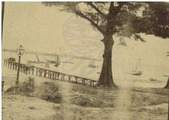
Foto 2: Porto Cais de Bolama - 1891 (Fonte: Instituto de Investigação Científica Tropical / AHU. Disponível em < http://actd.iict.pt/view/actd:AHUD7057 >. Acesso: 05/10/2015).
