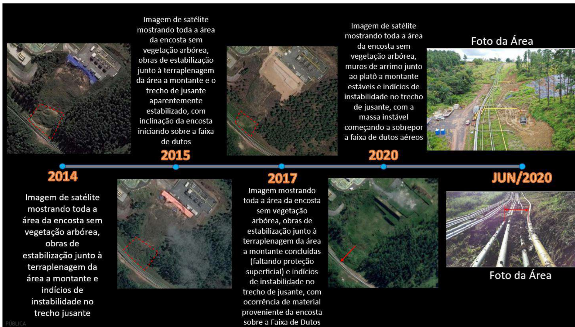
Figura 65 - Cronologia da Movimentação do Talude
