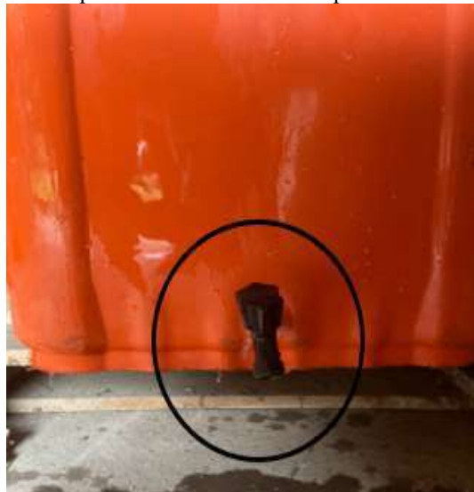
Figura 12. Adaptação da torneira na parte inferior do contêiner para retirada de líquidos percolados.
