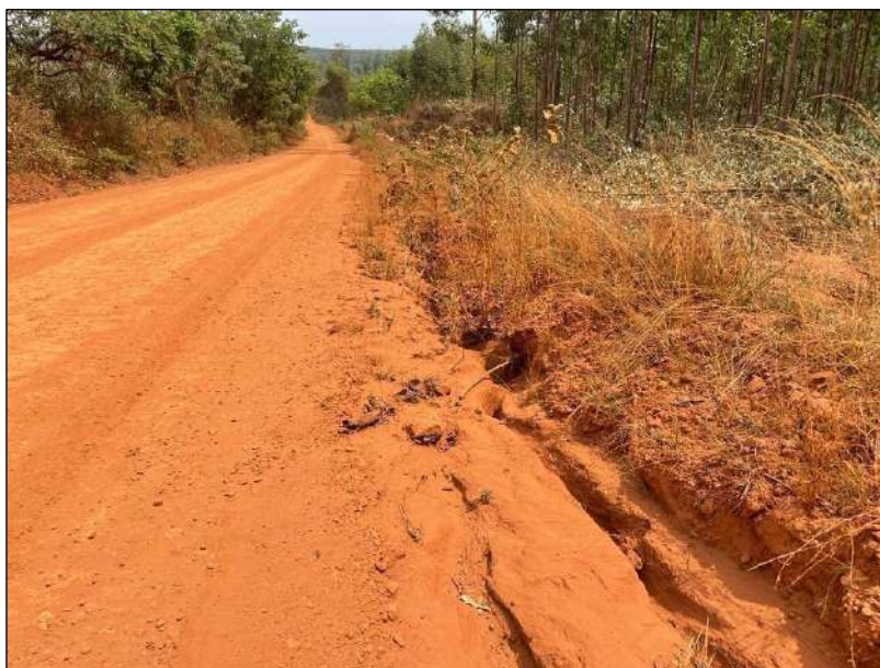
Figura 5.15 - Sarjeta da estrada que conduz a água até a bacia de captação em uma estrada rural da bacia do rio Formoso
