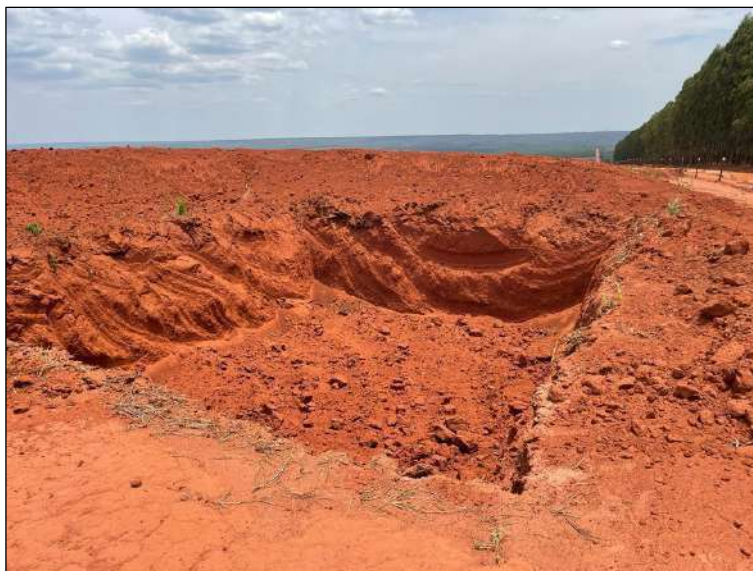
Figura 5.11 - Caixa de contenção de sedimentos em propriedade rural situada na bacia do rio Formoso
