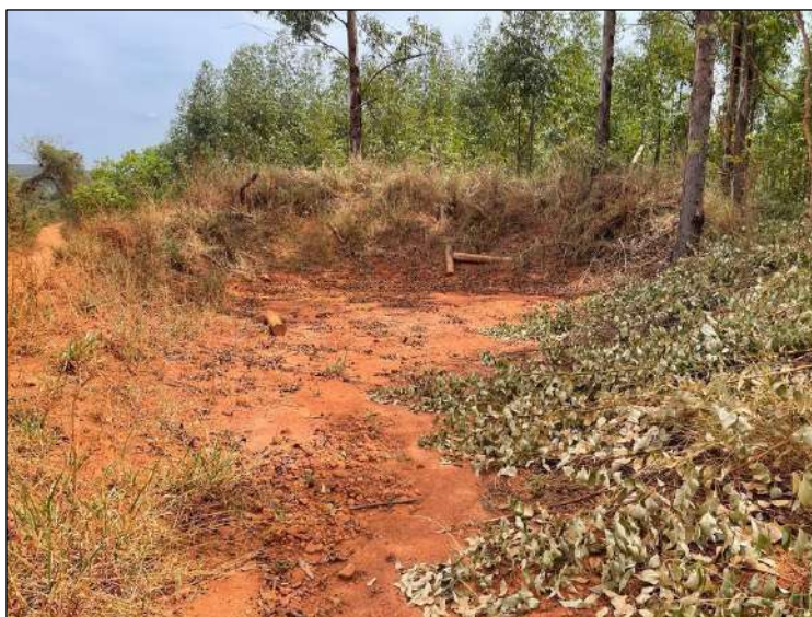
Figura 5.14 - Bacia de captação de água da chuva implantada em uma estrada rural da bacia do rio Formoso
