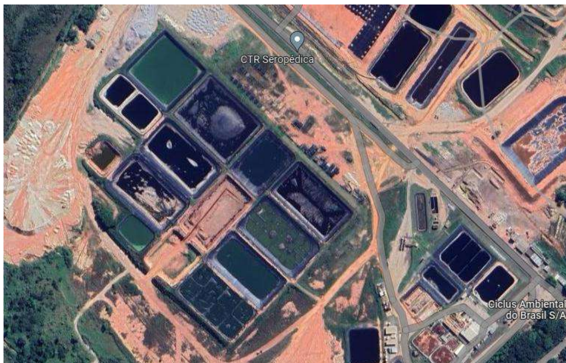
Figura 9 - Centro de Tratamento de Resíduos, Aterro Sanitário de Seropédica.
