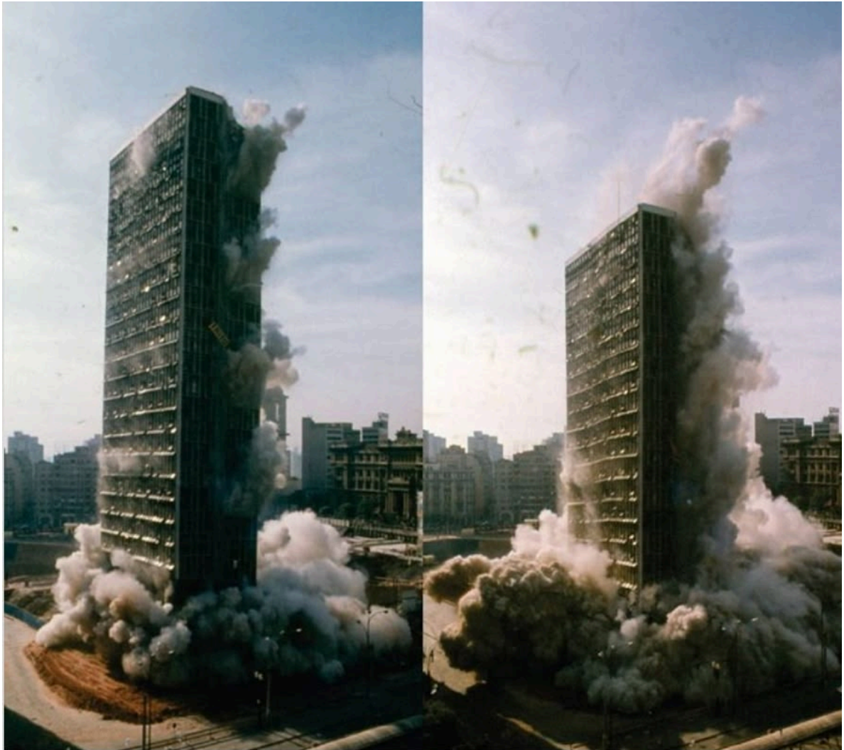
Fig. 40. Implosão do Edifício Wilson Mendes Caldeira, autor desconhecido, (1975)
