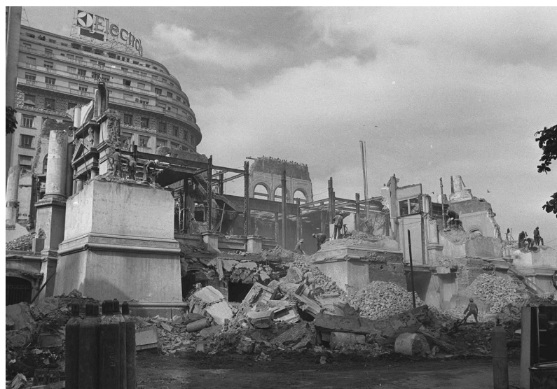
Fig. 38. Demolição do Palácio Monroe, autor desconhecido (1976).
