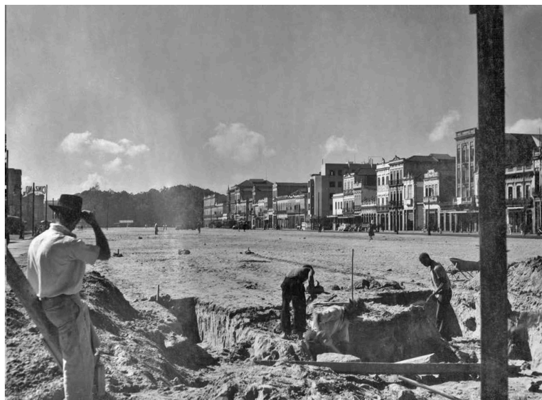
Fig. 125. Operários trabalham na abertura da Avenida Presidente Vargas, autoria desconhecida (1942)
