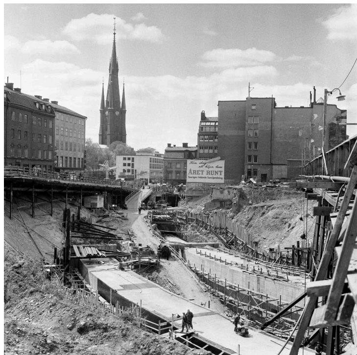
Fig. 124. Construção da linha verde do metrô de Estocolmo, por Herman Ronninger (1957)
