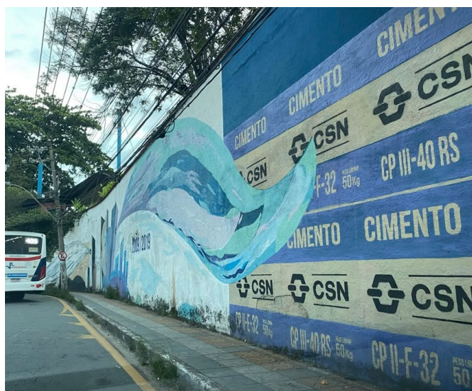
Figura 72: Pintura cobrindo pichação.
