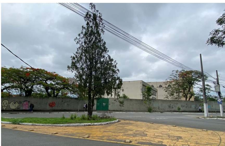
Figura 57: Muro do Colégio Estadual Rio Grande do Sul.
