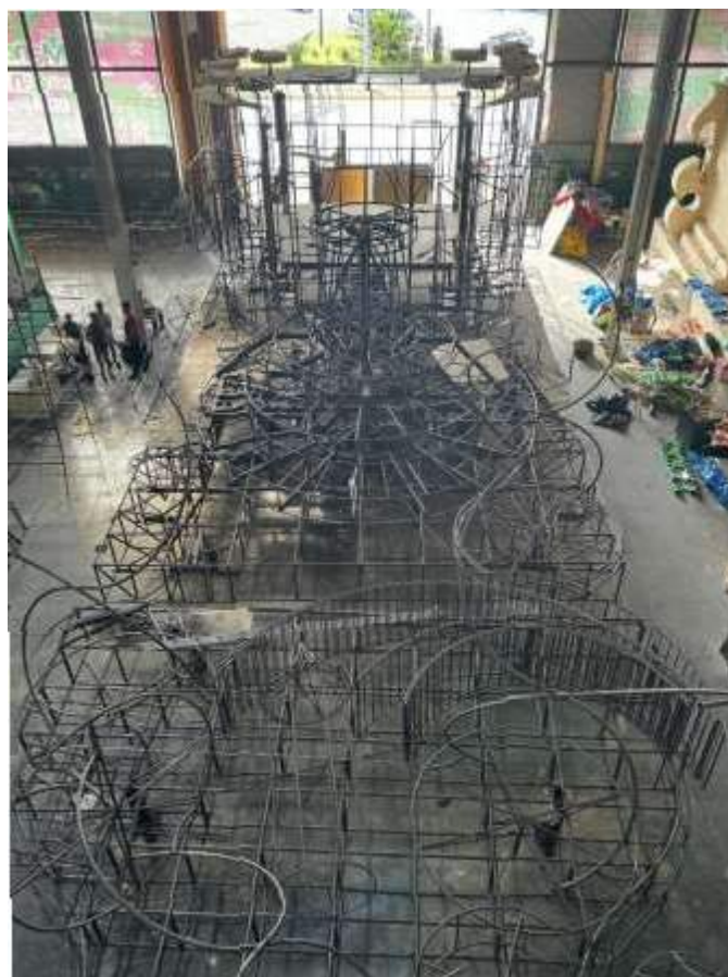
Figura 3 – Estrutura de ferro da 5ª alegoria do desfile de 2024, no primeiro andar do galpão.
