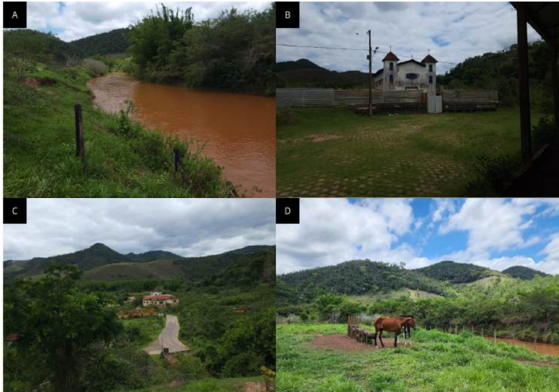
Figura 14 - Área Urbana de Paracatu de Baixo. (A) Corpo hídrico com aspecto turvo. (B) Igreja atingida pela lama após o rompimento da Barragem do Fundão (2015), e que está em processo de reconstrução. (C) Perímetro urbano onde é possível ver casas em segundo plano. (D) Paisagem com presença animal próxima ao rio poluído.
