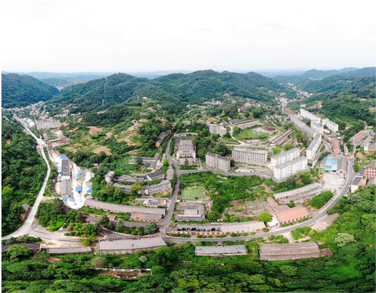
Figura 7 – Visão panorâmica da Factory 238 em 2019, província de Hubei. Fonte: Tan (2021)
