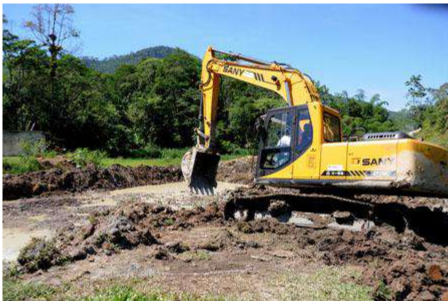
Figura 85: Fotografia ilustrativa do tipo tecnoforma de escavação em área de construção de lagos artificiais para a criação de peixes.
