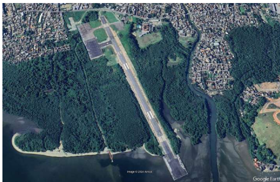
Figura 76: Imagem Google Earth Pro de 16/01/2024 com exemplo da tecnoforma de acumulação - aterro para construção da pista de pouso e decolagem do aeroporto regional Japuíba.
