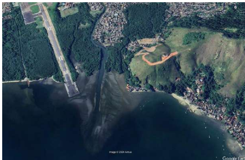
Figura 80: Imagem Google Earth Pro de 03/01/2024 com exemplificação do tipo geotecnóforma de acumulação - estuário assoreado.
