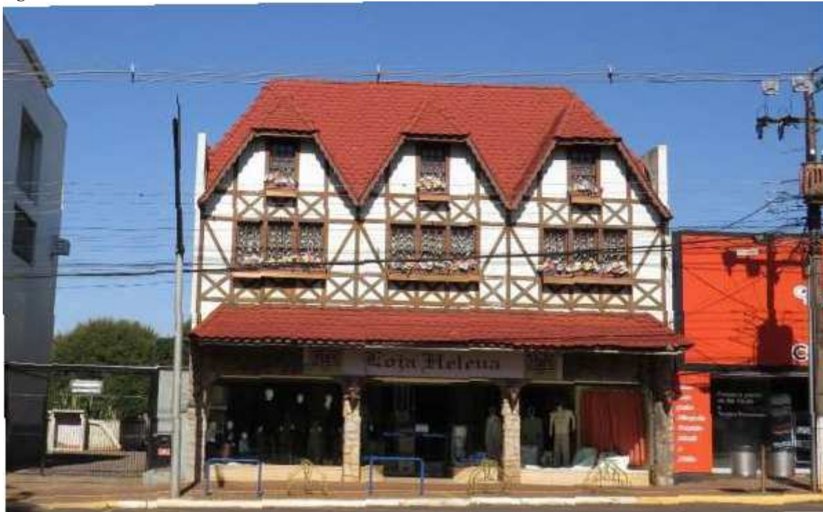
Figura 10 - Fachada comercial em estilo enxaimel - Marechal Cândido Rondon
