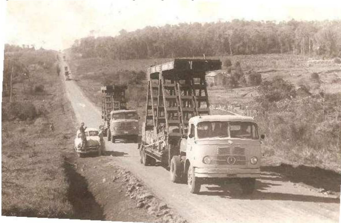
Figura 109 – BR 277 – Trecho de São Miguel do Iguaçu à época da abertura – 1968
