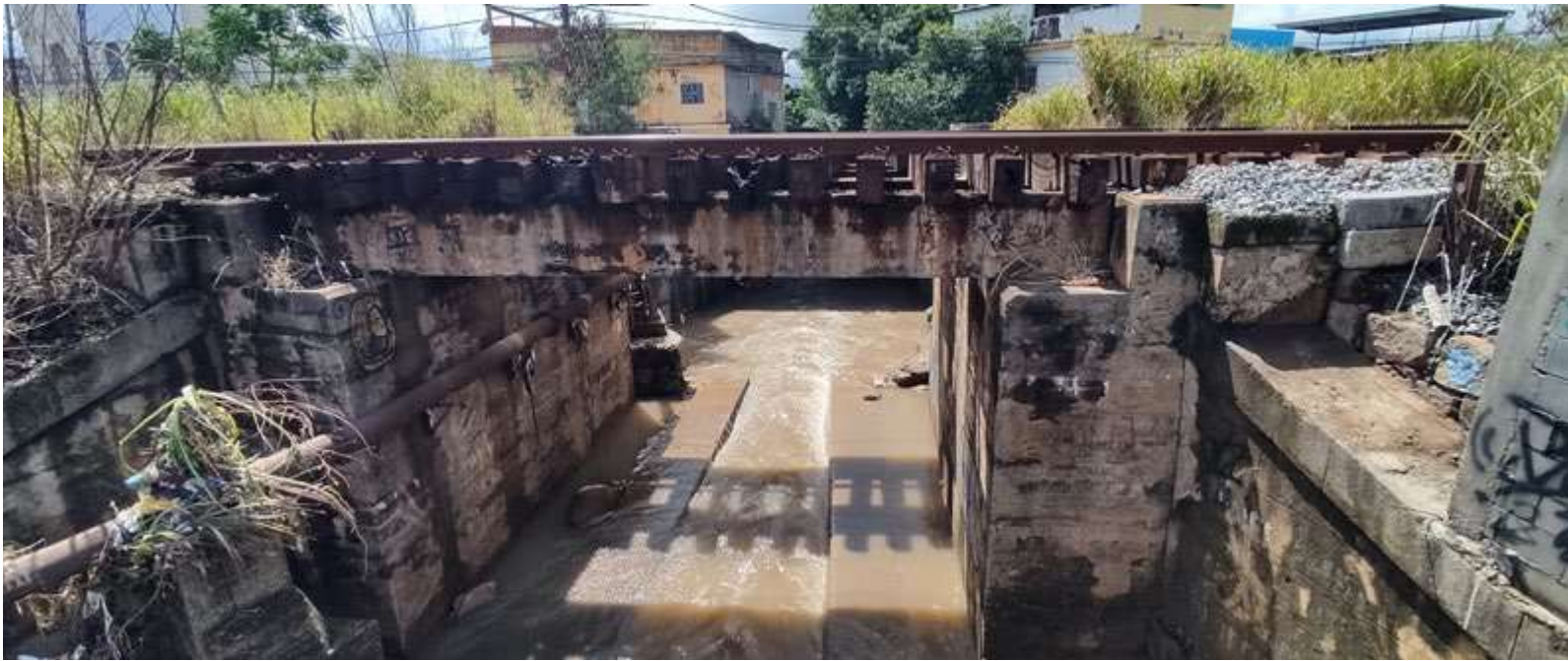
Figura 43 - Trecho do Rio Botas onde o Ramal Japeri “estrangula” o curso natural das águas, logo após a canalização proposta pelo município de Nova Iguaçu, 2022.
