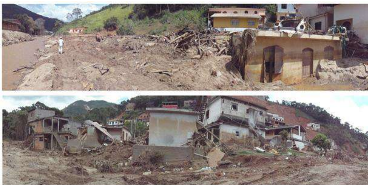
Figura 17- Casas destruídas por deslizamentos e enchente do córrego Dantas
