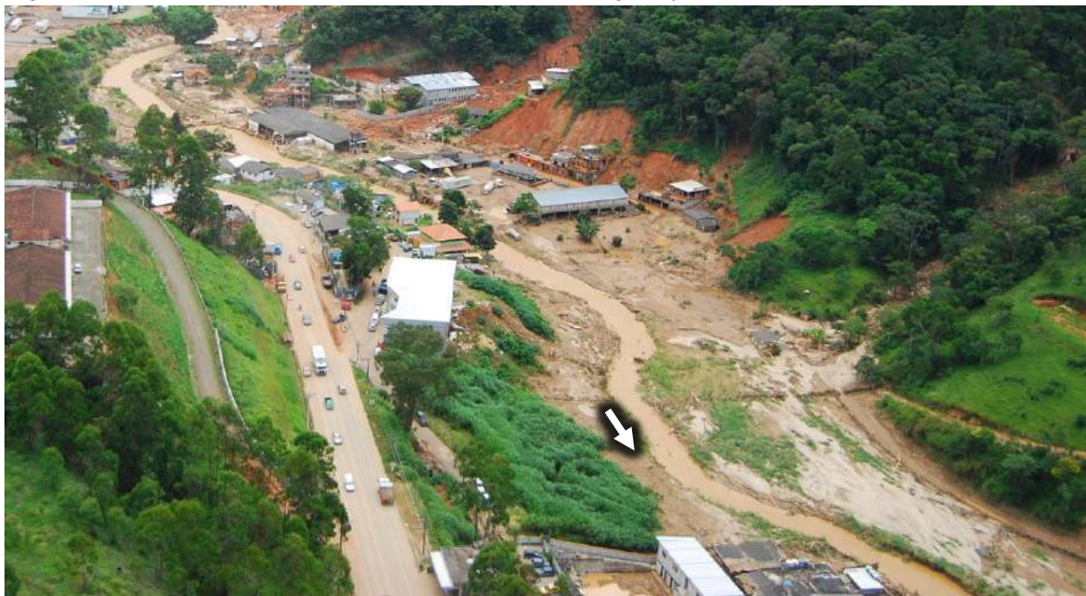
Figura 63 - Acresção vertical de depósitos de areia média e grossa em planície parcialmente confinada. Algumas casas soterradas indicam acúmulo de 2m em alguns pontos.
