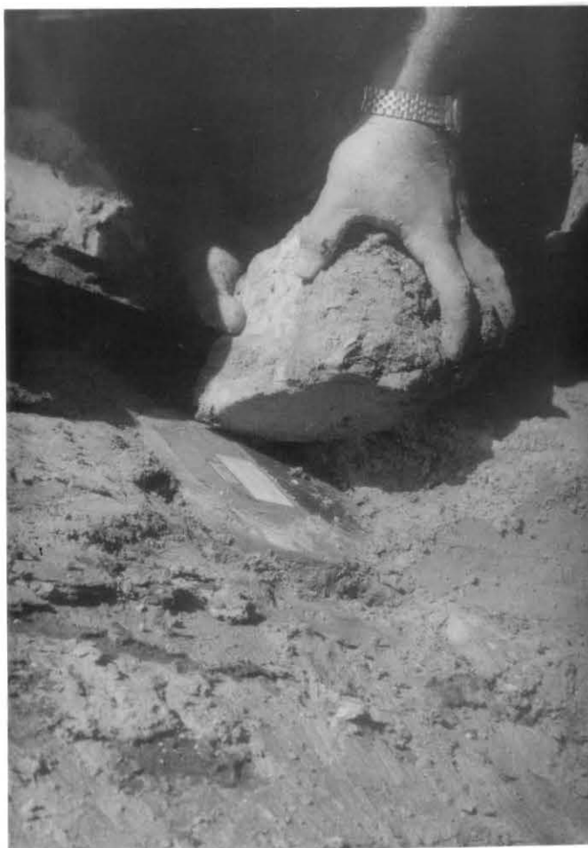
Foto 3 - Lote 9 (Botafogo) - Célula após instalação na parede diafragma.
