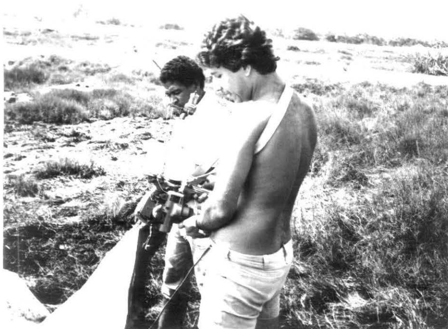
Foto 13 - Detalhe da Costura da Manta Geotêxtil
