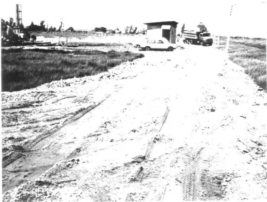
Foto 18 - Estado da Superfície da Estrada de Acesso (Pri meiras Passadas, Altura de Aterro \approx 0.6m ).
