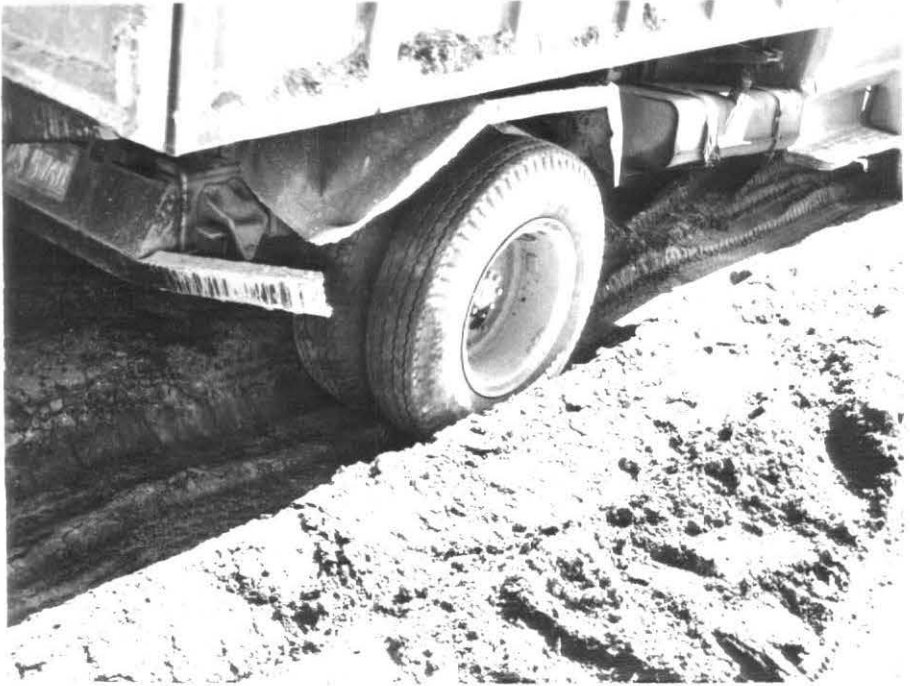
Foto 16 - Dificuldade de Tráfego Devido à Altura de Aterro e Características Mecânicas do Aterro Insuficientes ( H \approx 0,60m ).
