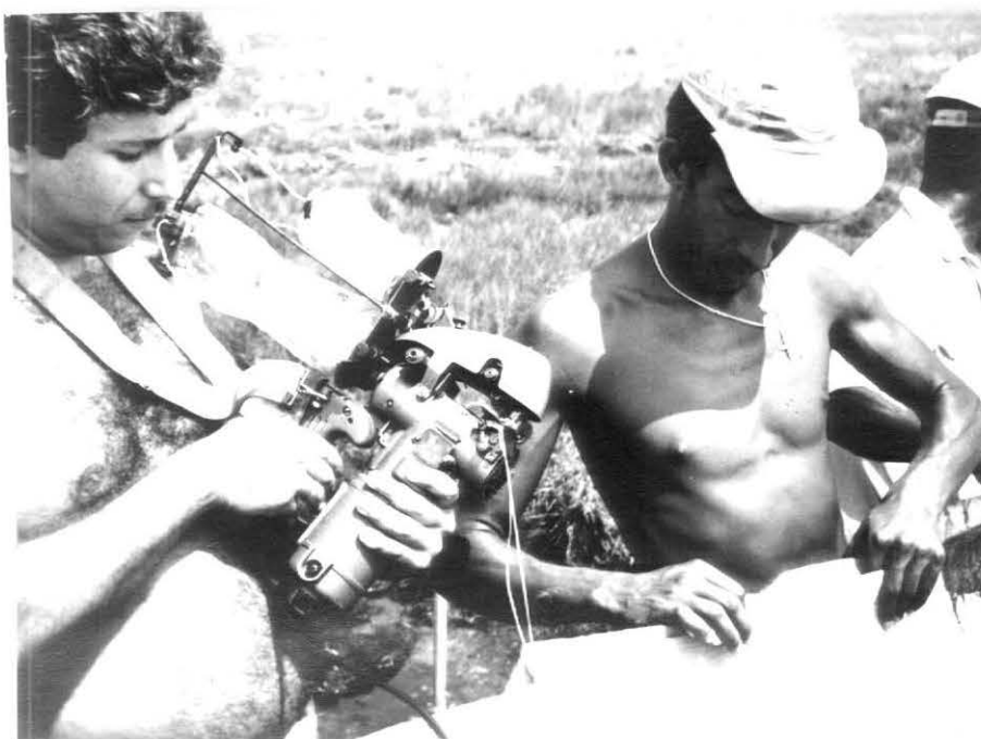
Foto 14 - Detalhe da Costura da Manta Geotêxtil
