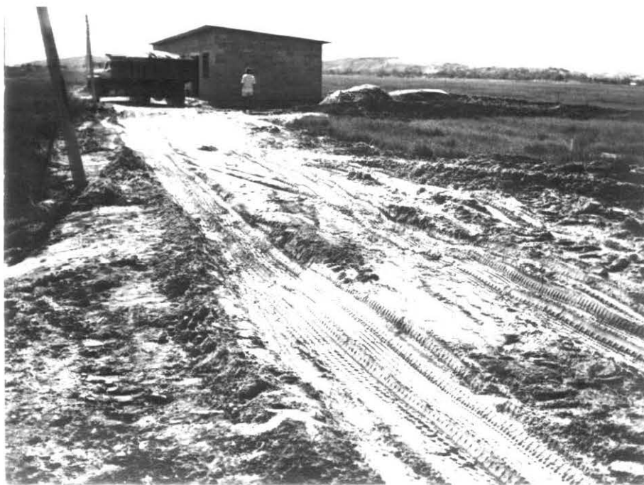
Foto 19 - Estado da Superfície da Estrada de Acesso (Pri meiras Passadas, Altura de Aterro \approx 0.6m ).
