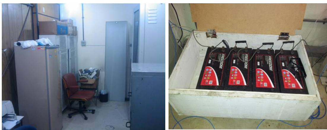
Figura 18 - Sala de telefonia e banco de baterias.
