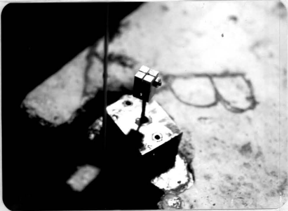
Foto IV.1 - Rótula de fundação
