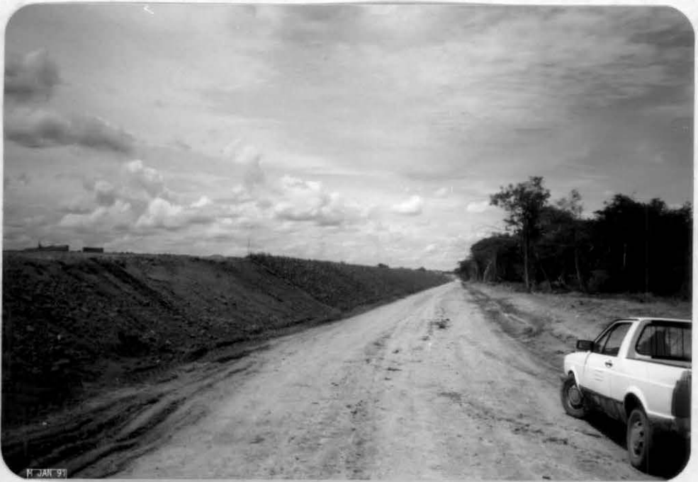
a) Aterro compactado
