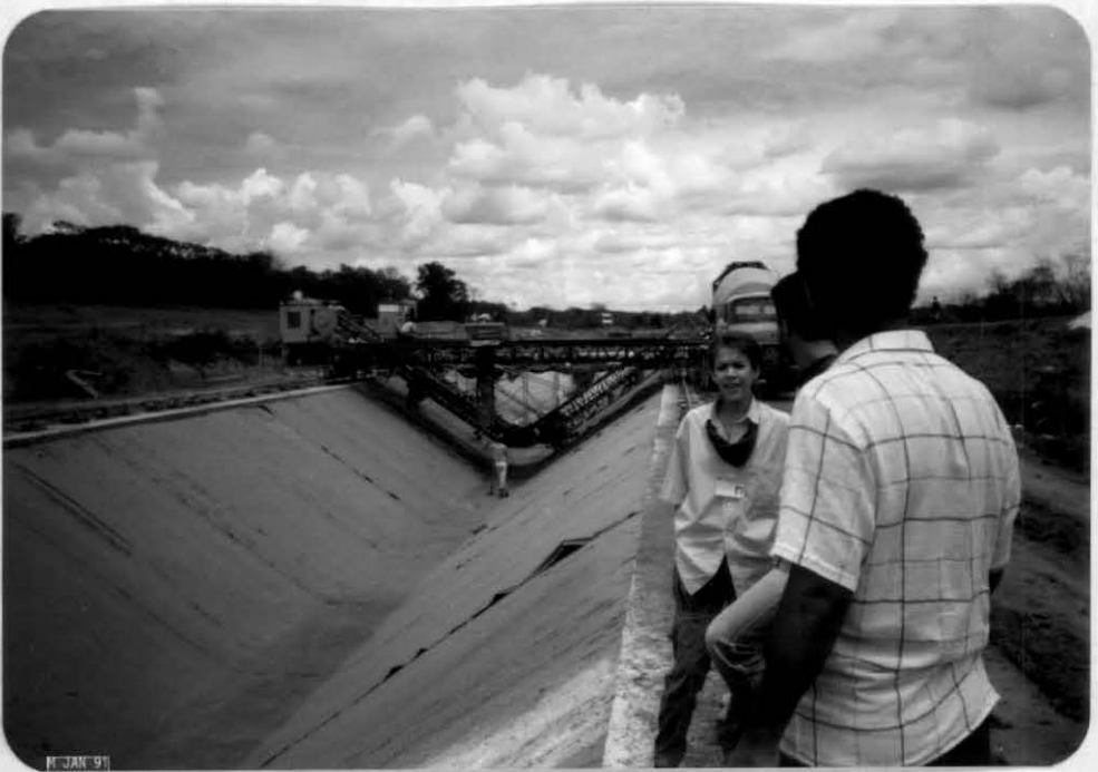
b) Impermeabilização do canal
