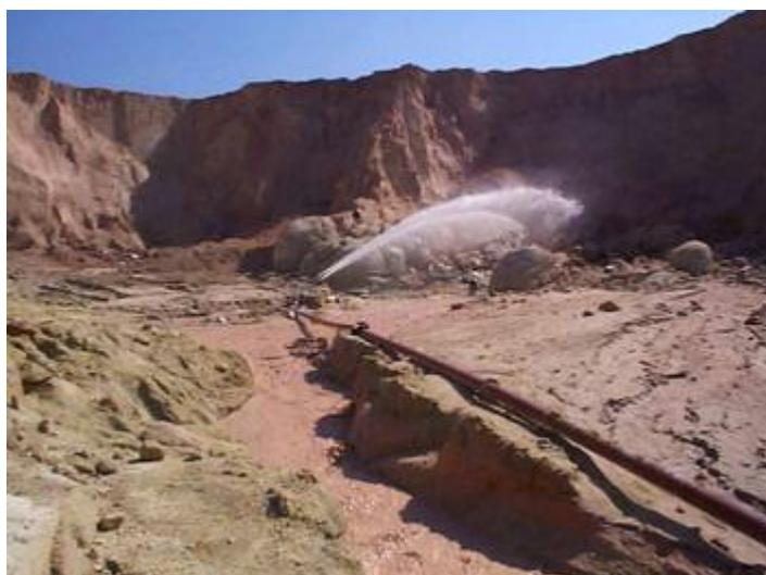
Figura 6 – Extração de areia por desmonte hidráulico
