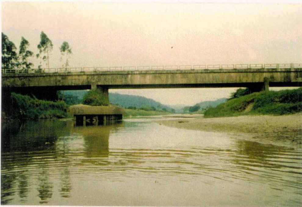
Figura 4 - Aspecto geral da estação de amostragem E2 (período de baixa pluviosidade)
