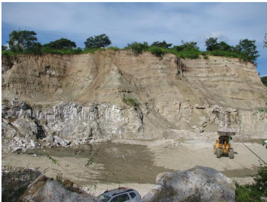
Figura 32 - Visão da frente de lavra da mina Pedra Branca, com destaque para o falhamento na porção esquerda que não parece afetar diretamente o Membro Ipubi.
